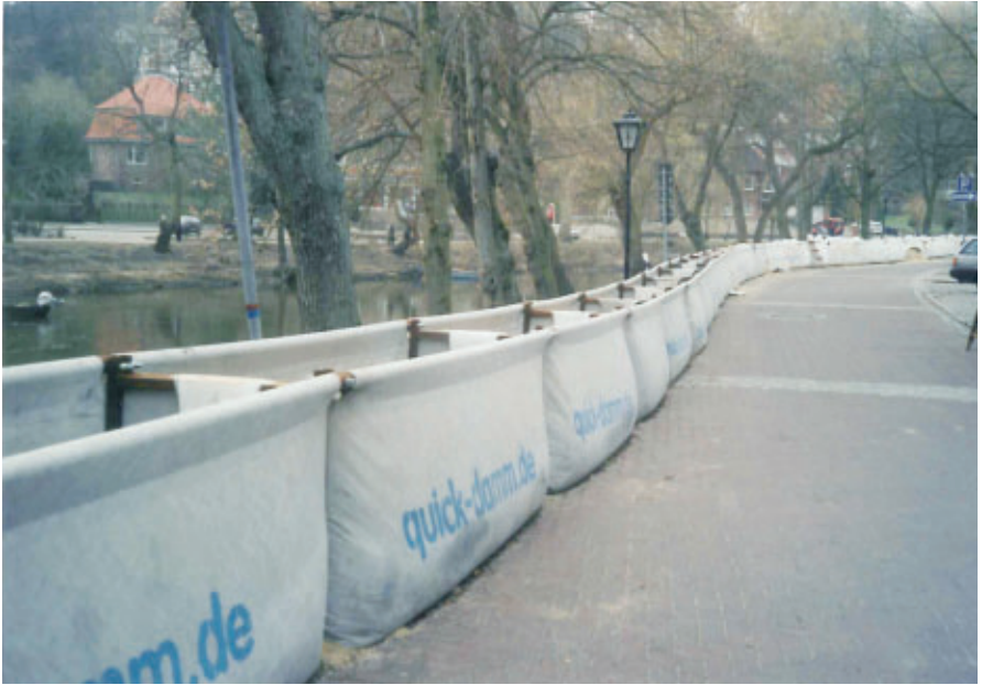
Elbehochwasser Januar 2003. Hitzacker-Altstadt. Mobiler Hochwasserschutzdamm
