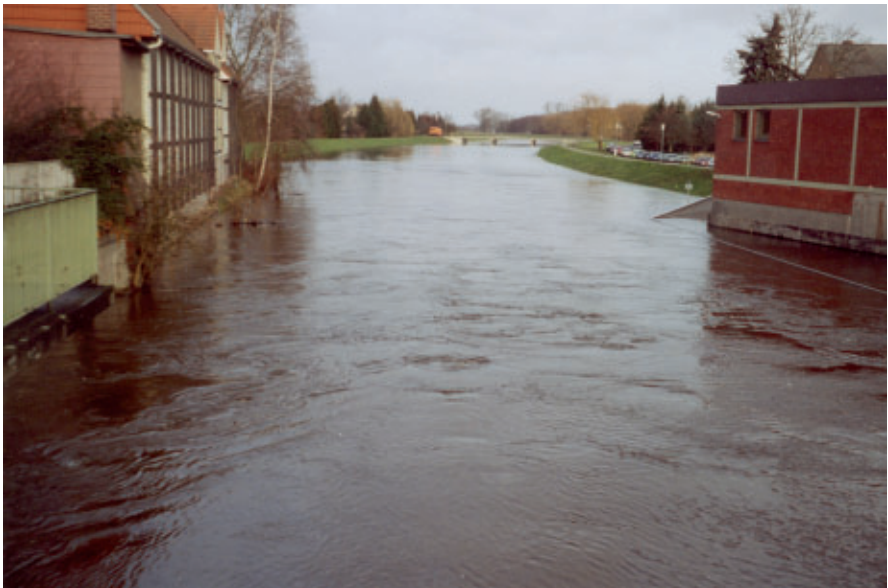
Jeetzelhochwasser 12.1.1994. Wehr Lüchow, Blick nach unterhalb
