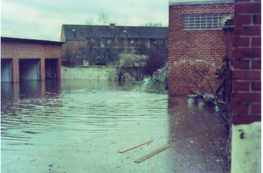
Elbehochwasser 17.12.1974. Hitzacker, überflutete Garagen
