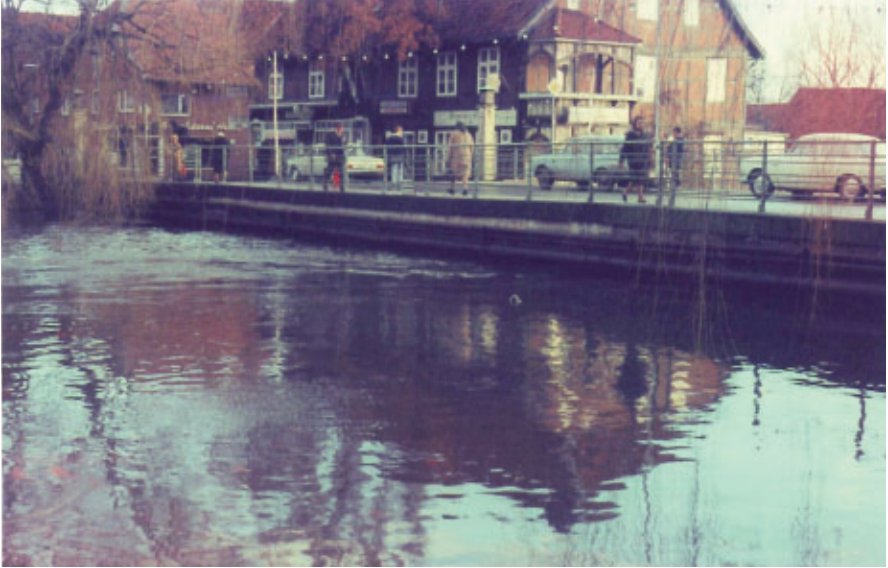
Elbehochwasser 17.12.1974. Hitzacker, Drawehnerbrücke. Blick von unterhalb.
