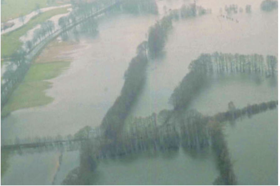
Elbehochwasser März 1981. Zwischen Kähmen und Streetz
