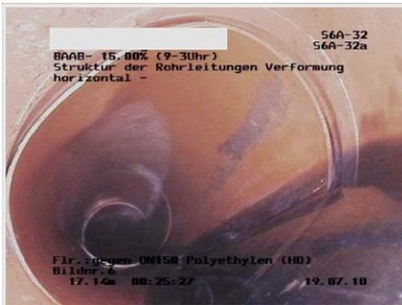
Abbildung 22 | Massive Rohrverformung
