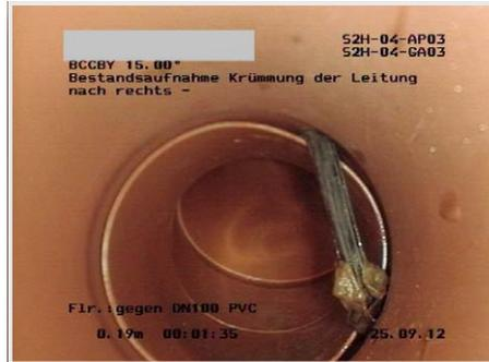
Abbildung 27 | Einragende Dichtung
