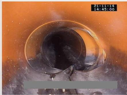
Abbildung 26 | Rohrbruch Kanalsohle
