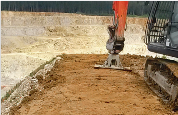
Bild 5-18: Verdichtung des Probefeldes Deponie Pfraundorf
