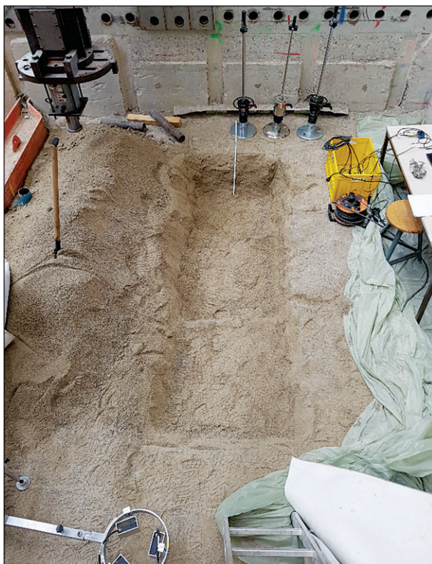
Bild 4-30: Aushub auf 45 cm, 30 cm und 15 cm
