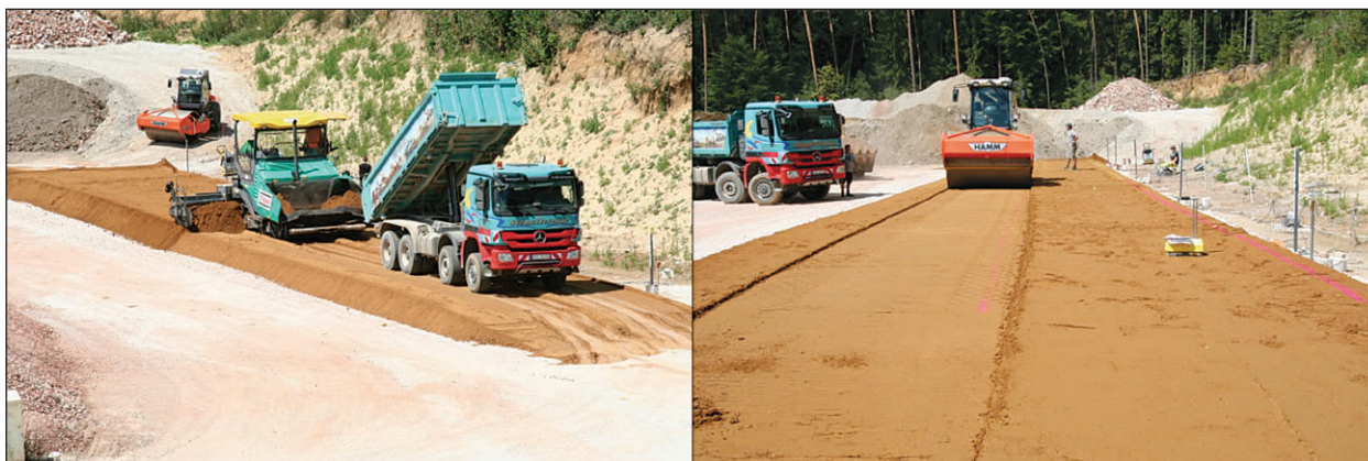
Bild 5-27: Erstellung eines Probefeldes aus „Grubenkies“ – Einbau (links) und Verdichten (rechts) der zweiten Lage mittels Straßenfertiger „Vögele Super 1900-3“ und Verdichtungswalze „H13i VIO“
