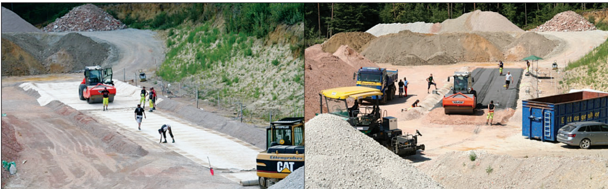
Bild 5-29: Herstellung der Wannenkonstruktion (links) und Erstellung des Versuchsfeldes aus EOS 0/4
