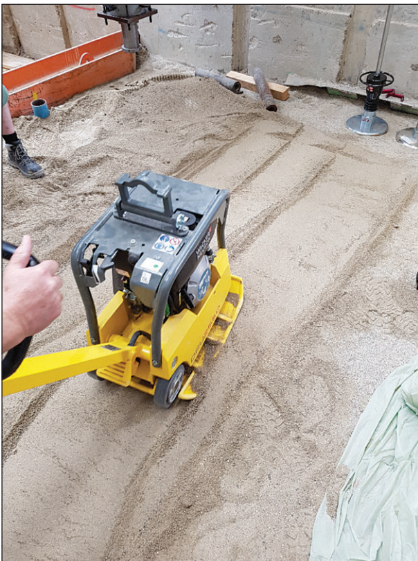
Bild 4-32: Wiedereinbau Boden, Verdichtung
