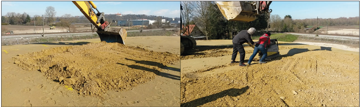
Bild 5-15: Einbau und Verdichtung des Probefeldes Westtangente Freising
