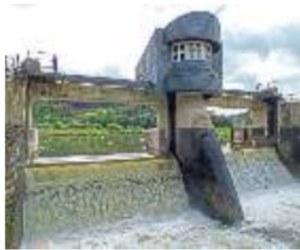
Umstritten: das Wehr am Aggerstau in Wiehlmünden (NRW)
