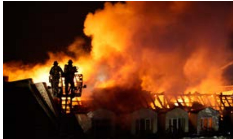
Der Dachstuhl brennt in ganzer Ausdehnung
