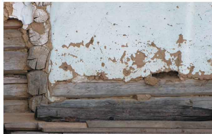
Tencuială tradițională din pământ, văruiță pe perete din bârne de lemn
