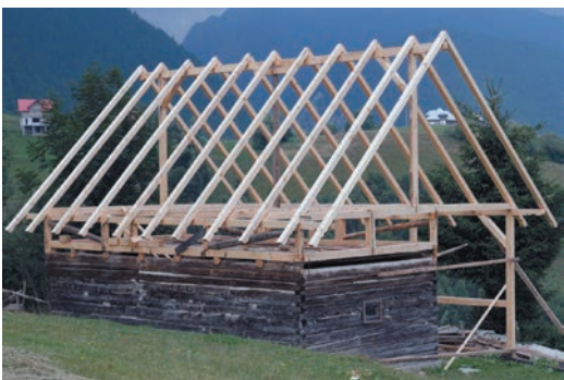
Reparație la o casă veche din bârne, satul Peștera
