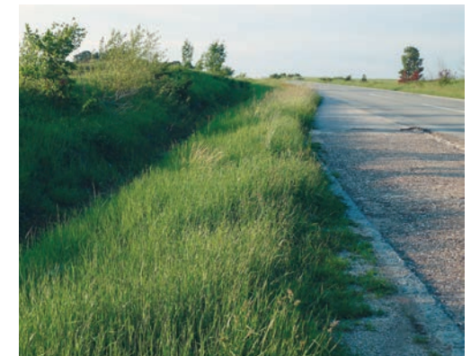
Exemple de drumuri (sus: drum tip defileu, exemplu de scurgere transversală a apei, pentru împiedicarea erodării drumului, mijloc: drum de acces înierbat, jos: drum pavat cu piatră, drum asfaltat cu rigole laterale înierbate)
