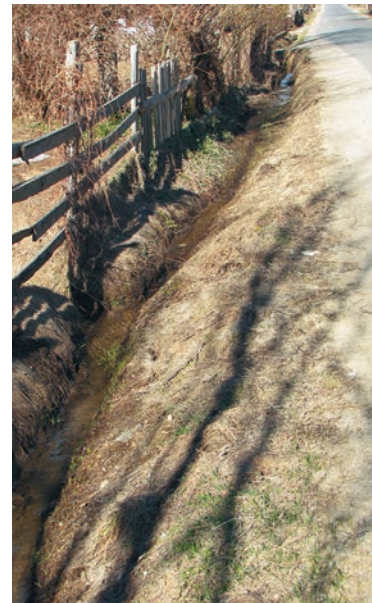
Șanțul înierbat reduce viteza de curgere a apelor și împiedică erodarea excesivă.
