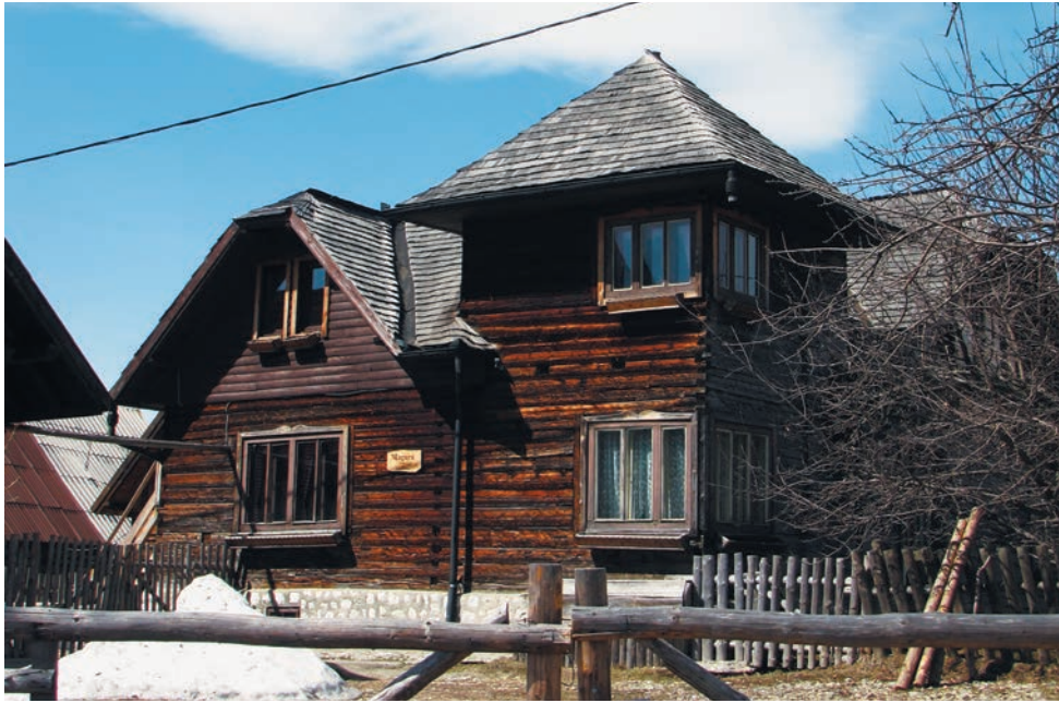
Casă din bărne cu acoperiș armonios și învelitoare din șită, satul Măgura
