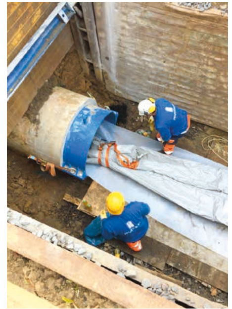
In den Baugruben wurde als Verlängerung der Rohrleitung eine Kalibrierhülse installiert. Sie diente als Außenschalung für den Liner und sorgte für ein definiertes Außenmaß und die Rundheit des Liners.
