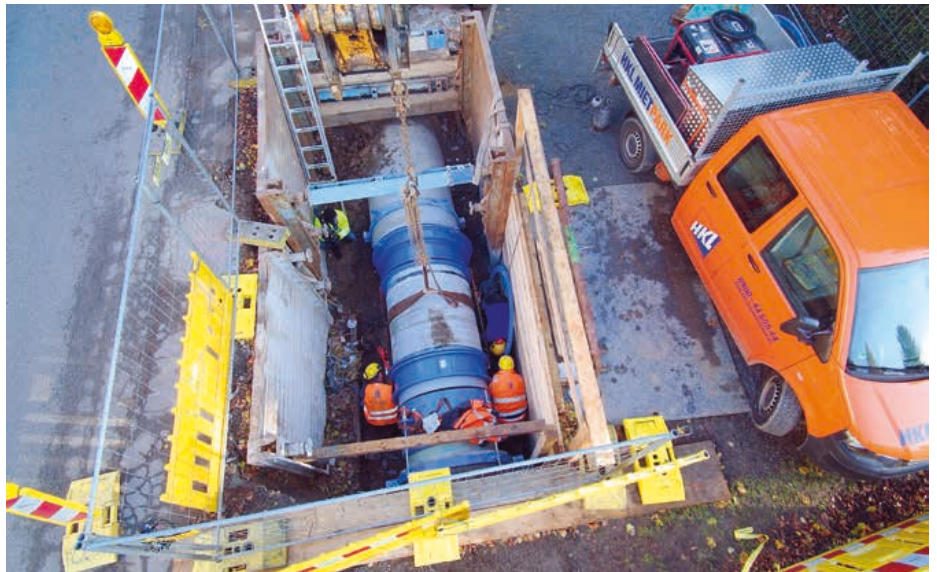
Wieder verbinden der sanierten Rohrleitung. | Fotos: Pfaffinger
