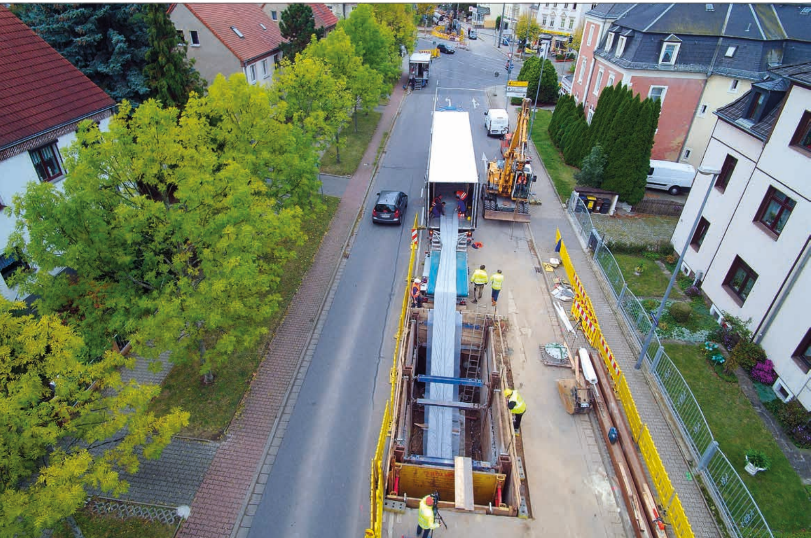
Einzug eines der bis zu 103 Meter langen Liner.
