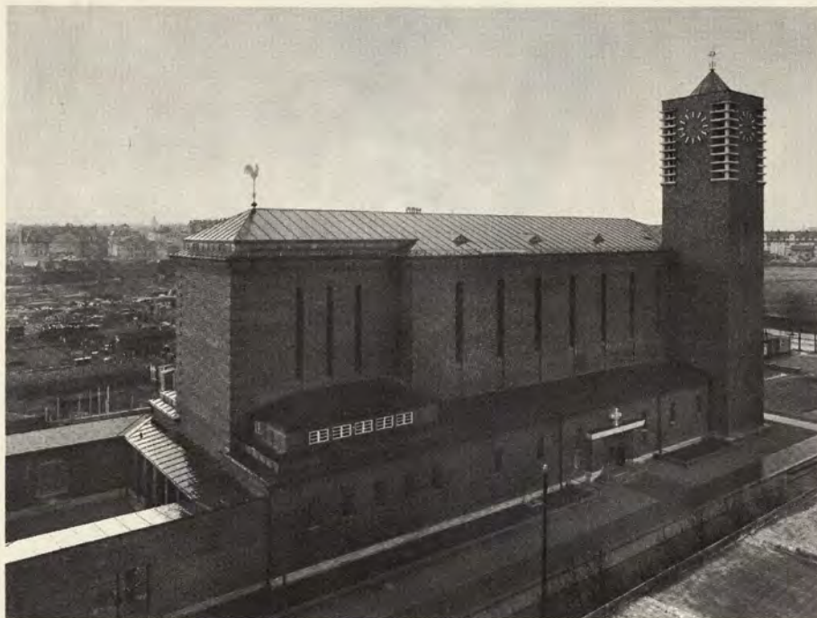
Noch stand sie auf freiem Feld, die von Otho Orlando Kurz und Eduard Herbert erbaute Kirche St. Sebastian, als sie am 10. November 1929 eingeweiht wurde. Doch schon übers Jahr war sie von einem Wohngebiet umgeben.
