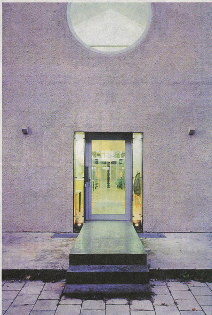
Erst Kapelle, jetzt Büro – mit enormer Deckenhöhe
