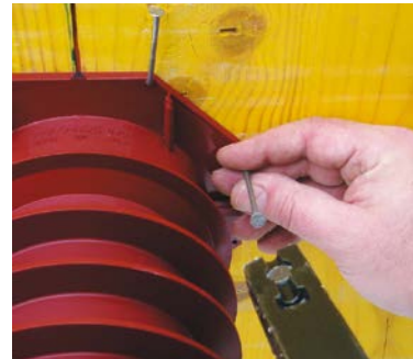
Das Lamellenrohr an die Schalungswand annageln.
