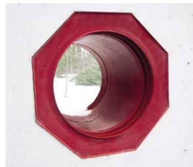
POLO-RDS evolution Lamellenrohr fertig einbetoniert.
