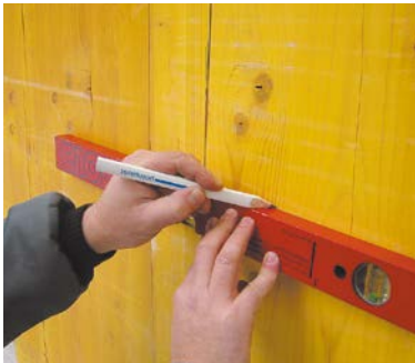
Lage der Rohrachse an der Schalungswand anzeichnen.
