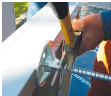
Zweite Schalungswand aufstellen, Schalungsanker anziehen.
