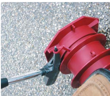
Das Lamellenrohr auf Wandstärken 20 cm oder 25 cm durch Abziehen der Abreißelemente kürzen.
