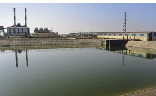
Ein 20 MW Kohlekraftwerk und 2 x 15000 m 3 Wasservorrat machen die Fabrik komplett autark.
