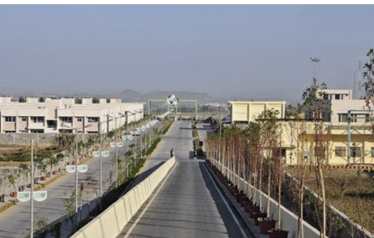
Besonderheit: Auf dem Werksgelände gibt es über 400 Apartments, wo ein Teil der insgesamt 1700 Mitarbeiter wohnt. Für indische Verhältnisse der pure Luxus.
