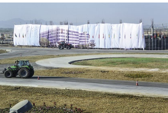
Noch im Bau war das 25 ha große Testgelände. In dem Gebäude sollen auch Rollenprüfstände entstehen. Erste Testschlepper drehten aber schon ihre Runden.
