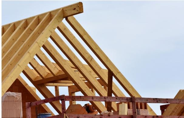
Abbildung 4: Holz beim Bau eines Dachstuhls
