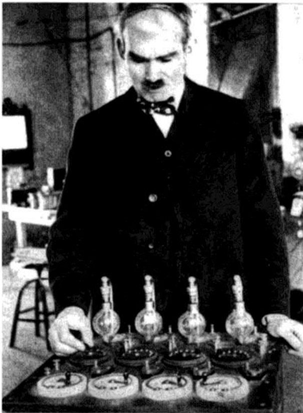
Bild 22: De Forest mit vierstufigem Audion-NF-Verstärker [2].
