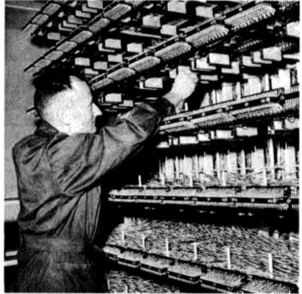
Bild 2: Hauptverteiler mit steckbaren Zentralenfiltern. Hasler AG, Bern.
