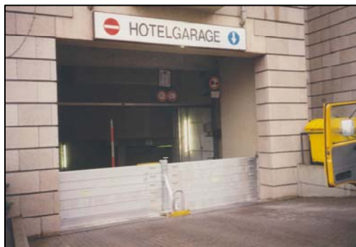
Abbildung 15 Einsatz von Dammbalken
