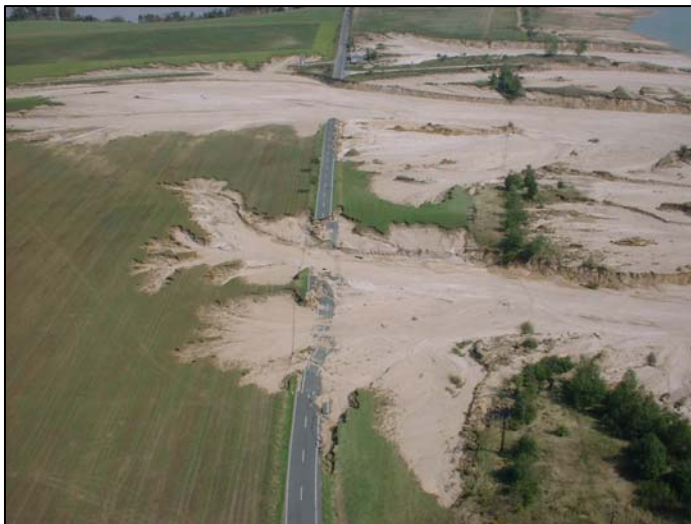
Abbildung 10: Hochwasserschäden an Bahngleisen und Bundesstrassen
