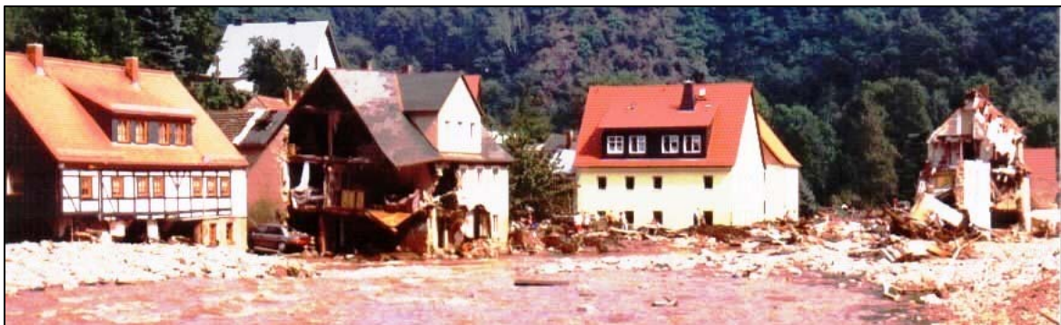
Abbildung 2: Hochwasser 2002 – Wesenstein, Zerstörungen durch Sturzflut,
