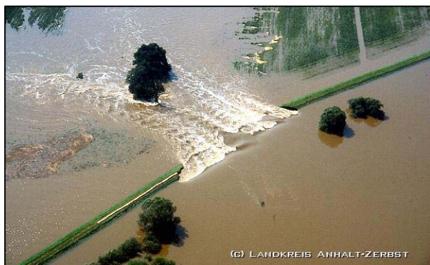
Abbildung 20: Deichbruch während des Hochwassers an Elbe und Mulde 2002
