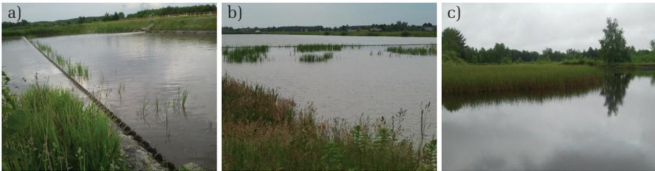
**Abb. 7.2.** Teile der Beckenkammer im *KWB Bełchatów*: a) Vorklärbecken, b) Nachklärbecken, c) Pflanzenfilterzone
