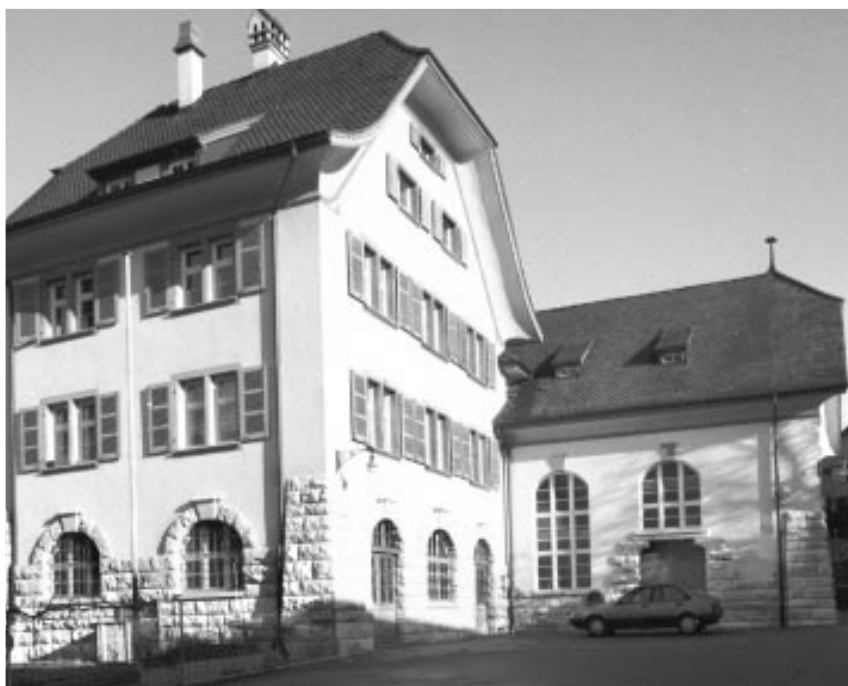
Gegenstand der Kaufverhandlungen zwischen der IWB und der Gewerbehaus AG: Magazin- und Wohngebäude der IWB am Friedhofweg 6.
