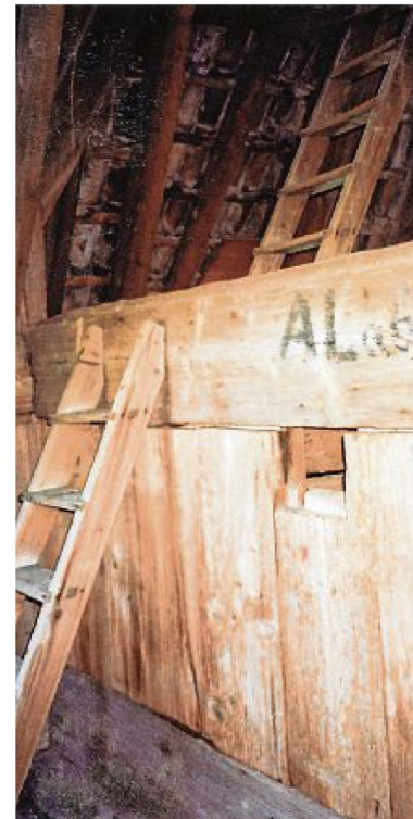
Das original erhaltene „Kastengefängnis“ des Reformators Jan Hus im Westturm.
