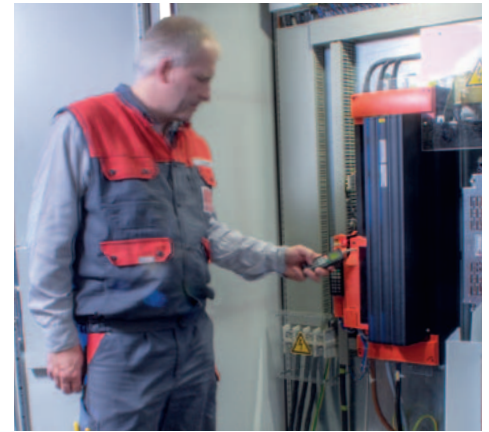
Moderner Frequenzumrichter zur Speisung des drehzahlveränderlichen Hochdruckpumpenantriebs
