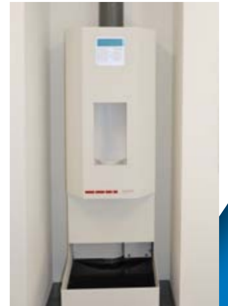
Bilder unten: Mittels einer Wasseraufbereitungsanlage wird das Brauchwasser speziell für die hohen Anforderungen im Krankenhausbetrieb gefiltert. Anders als herkömmliche Wasserfilter arbeitet diese Anlage auf Molekularbasis und kann auch gelöste Stoffe aus dem Wasser entnehmen. Mit Hilfe von Natriumchlorid, in Form von Salztabletten, wird das Tauscherharz in den blauen Drucktanks regeneriert.
