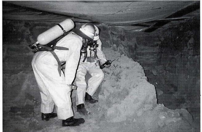
Daraufhin wurde festgelegt, daß die Baugrube nur noch von Einsatzkräften mit umluftunabhängigen Atemschutzgeräten begangen werden darf. Die Messungen mit Toximetern ergab, daß die Dämpfe aus einem lokalisierten Teil der Fundamentgruben, aber auch aus einem Teil des Bodenaushubes austraten.
