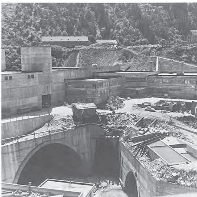
Das Nordportal mit Vortunnel (gedeckte Tunnelzufahrt) und Werkhof (Bildmitte).
