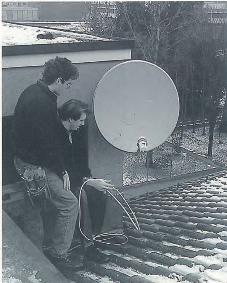
Installation des Satellitenempfangsspiegels, ausgerichtet auf das Astra-Satellitensystem.
