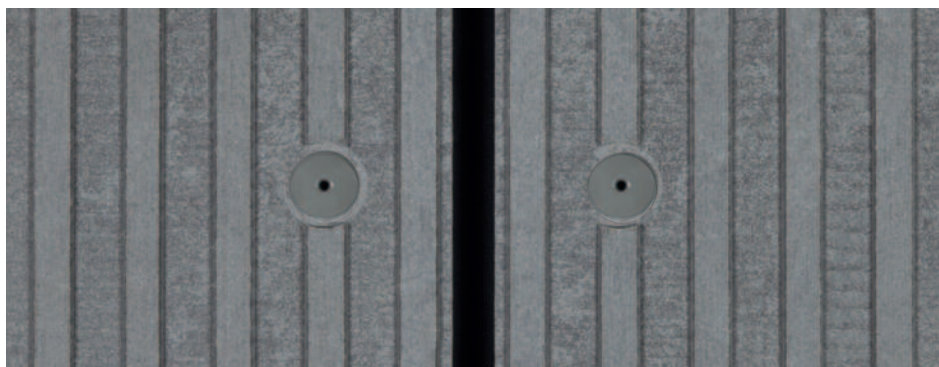
Befestigungspunkt auf Aluminiumunterkonstruktion; Befestigung in der Achse des Profilberges.
