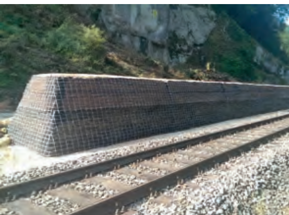
Werk Nr. 31, erstellt mit Stebo-Steilböschungssystem bei Dägenauer BL.
