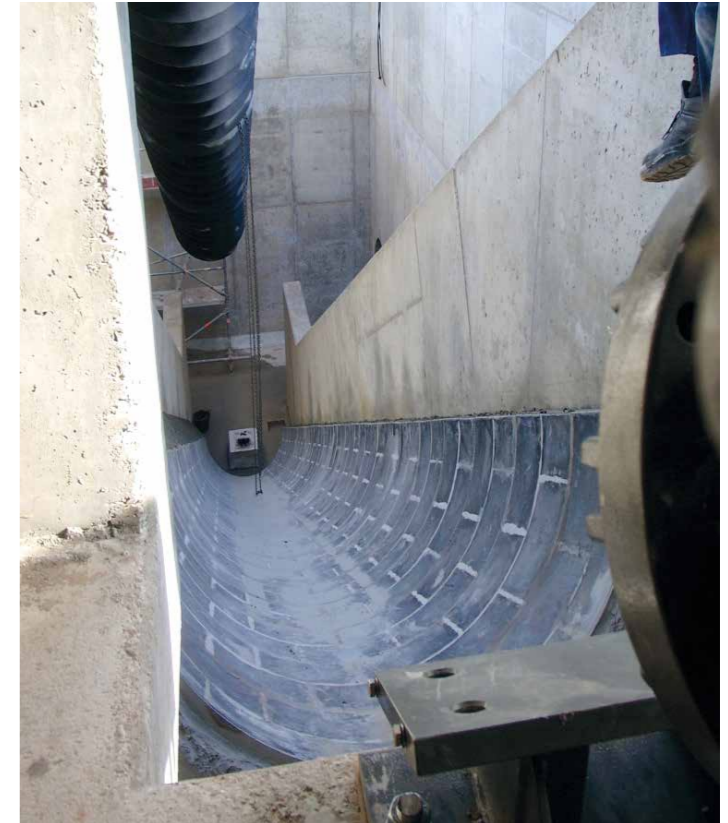
Saniertes Schneckenbett vor Einbau der Förderschnecke
