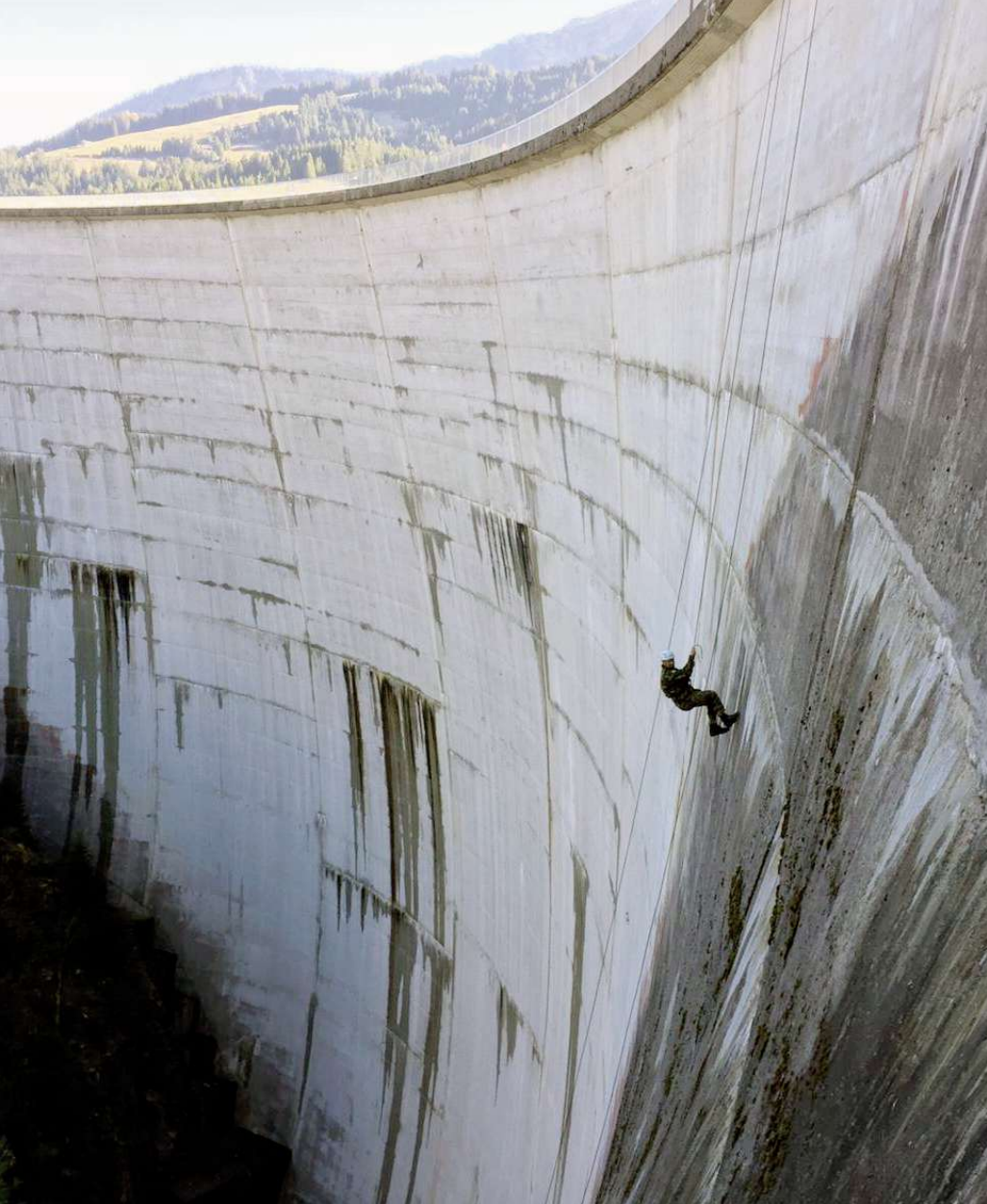
Phase «CLIMB» an der Staumauer des Lac de Hongrin: Abseilen über 42 Meter.
