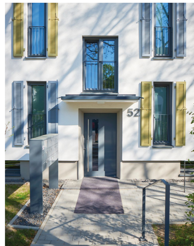
Das sanierte Bestandsgebäude Bierstadter Höhe 52
