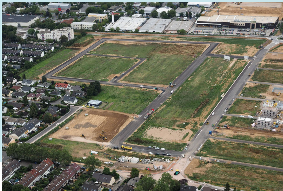
Die fortgeschrittenen Erschließungsarbeiten im Neubaugebiet Hainweg in Nordenstadt sowie erste Bautätigkeiten
