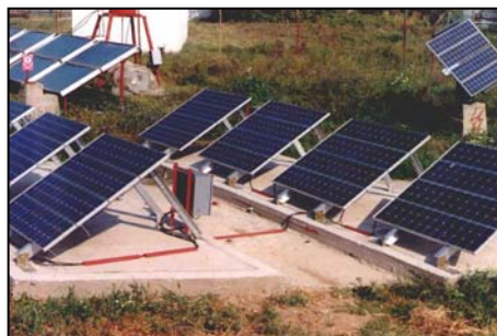
Fig.a Staie pilot termofotovoltaica pentru o ferma taraneasca in Romania
