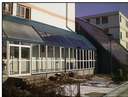
Fig.b Amfiteatru PV solar – Universitatea Valahia din Targoviste(vedere exterioara)
