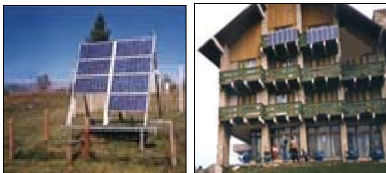
Fig.c Unitati standard de putere PV pentru protectia mediului in zonele montane izolate (Fundata si Predeal)
