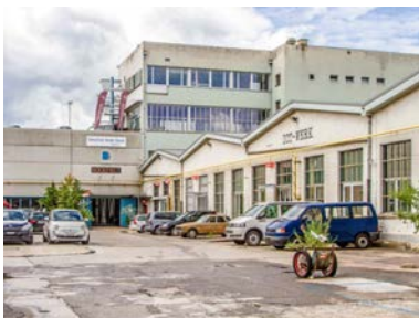
Münchenstein/Arlesheim, Tramstrasse 56-66, Industriestrasse 62-64
