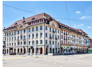
Basel, Schwarzwaldallee 171, Riehenstrasse 183
