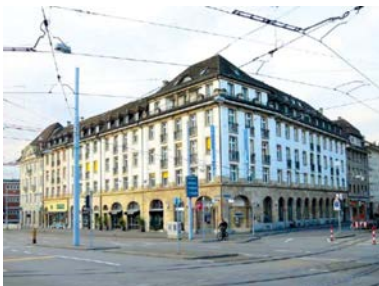
Basel, Schwarzwaldallee 175, 179 / Rosentalstrasse 70
