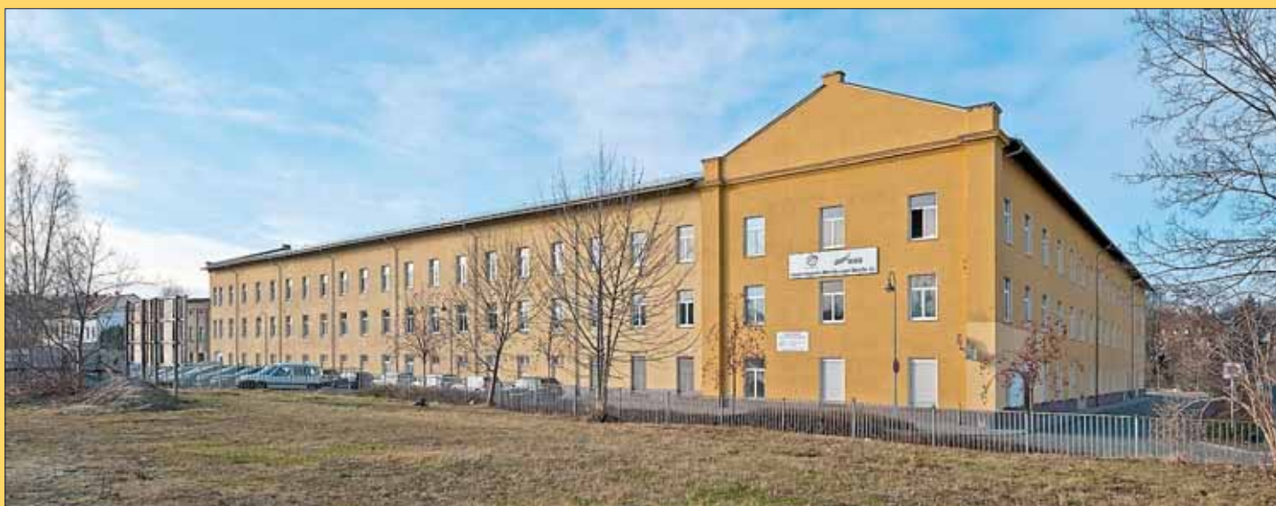
saniertes und vermietetes Gewerbeobjekt in Schmölln, Pos. 18
