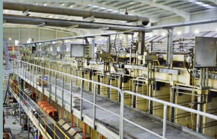
Hydraulik teilweise erneuert
