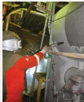
Staubarme Strahltechnologie mit Sponge-Jet
