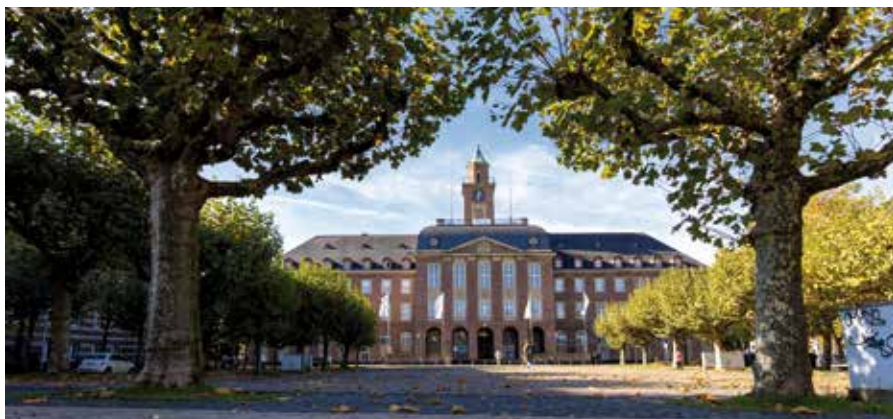
Ein Blick auf die Turmuhr zeigt auch von Weitem die genaue Uhrzeit. Der Durchmesser der Ziffernblätter beträgt 2,40 m.
