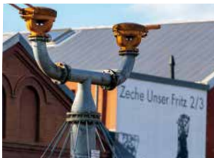
Die Protegohauben vor dem Maschinenhaus dienen als Ventile für den Gasaustritt.
