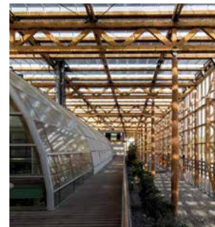
56 Fichtenstämme stützen die 180 m lange und 75 m breite Glashülle.
