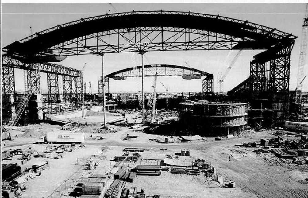
Bild 7: Verwendung von HISTAR Güten in Fachwerken (Bank One Ball-Phoenix)
