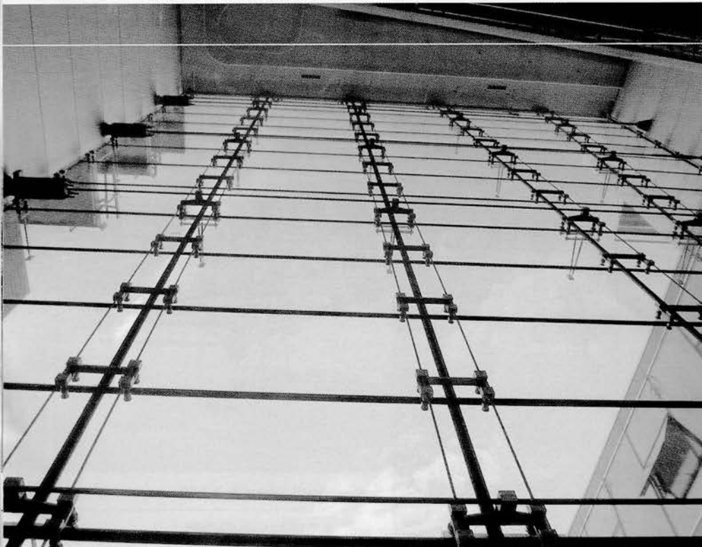
Bild 1: Seilhinterspannte Glasfassade, Innenansicht von unten nach oben
