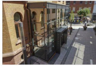
Neu: der Hintereingang mit Glasfassade und Aufzug.
