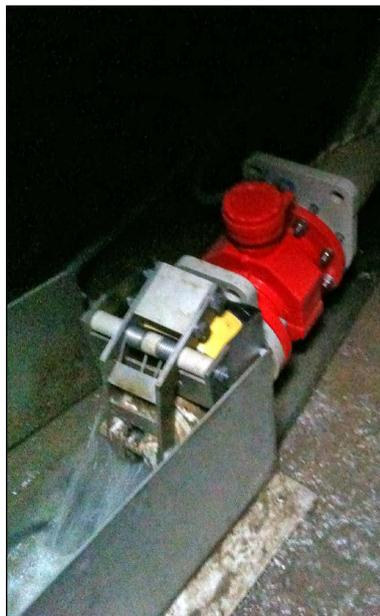
*Die pneumatische Abflussregelung kann ohne bauliche Massnahmen in das bestehende Gerinne integriert werden.*
