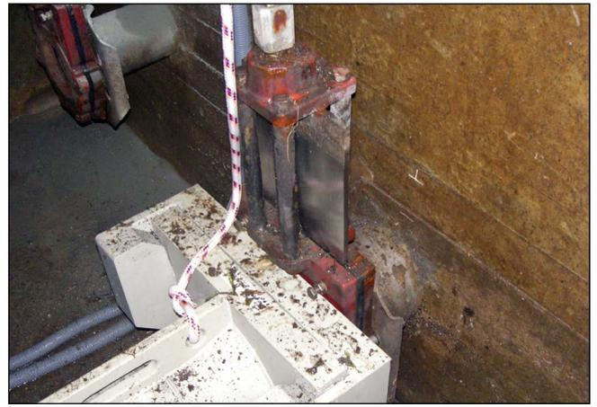
*Anschluss der pneumatischen Abflussregelung mit Einhängedaption an den vorhandenen Plattenschieber.*
