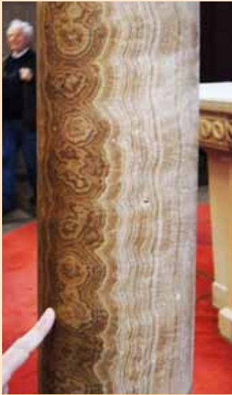
Abb. S 2.1 Aquäduktkalkstein (= -kalksinter) aus römischer Wasserleitung , mit ca. 2.000 Jahren einer der jüngsten in Deutschland verwendeten Naturwerksteine; Klosterkirche Maria Laach, Altar- raum, Säule [Foto: Schroeder]
