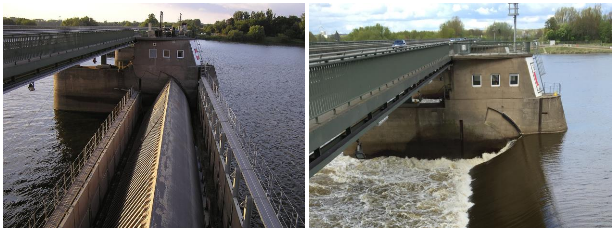
Abb. 11 li.: Sektorenwehr während Wartungsarbeiten, re.: Wehr in Betrieb bei MW
