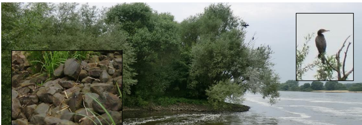
Abb. 53 Das südliche Elbufer unterhalb der Staustufe Geesthacht weist nur an Land eine naturnahe Vegetation auf, die Uferbereiche sind weitgehend durch Steinschüttungen befestigt (Foto: BBS 2015)
