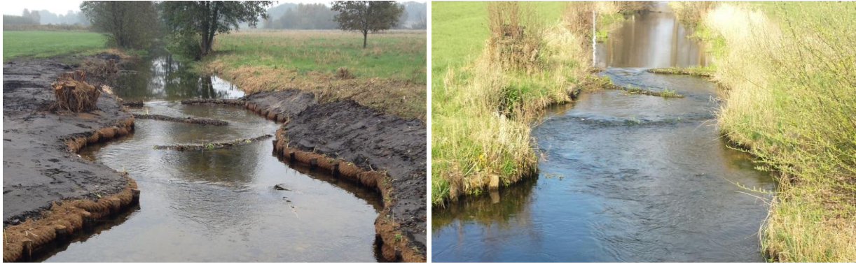
Abb. 67 Beispiel Schwellen-Becken-Pass mit Stein-/Röhrichtwalzen (Delvenau/Randgraben)
