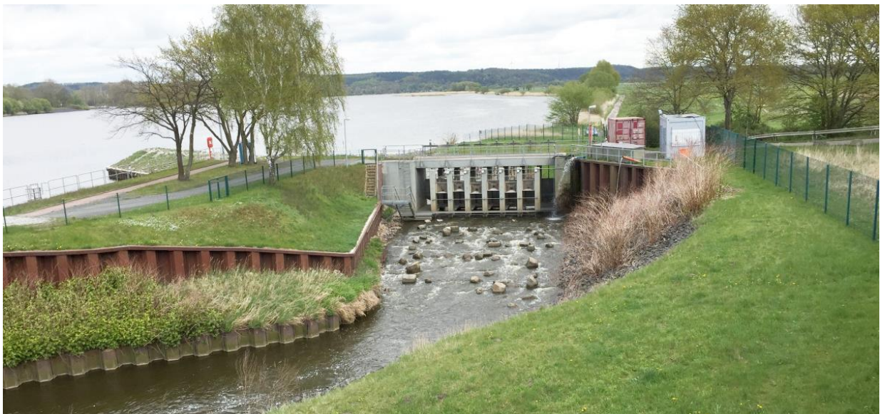
Abb. 13 Fischaufstiegsanlage am südlichen Elbufer
