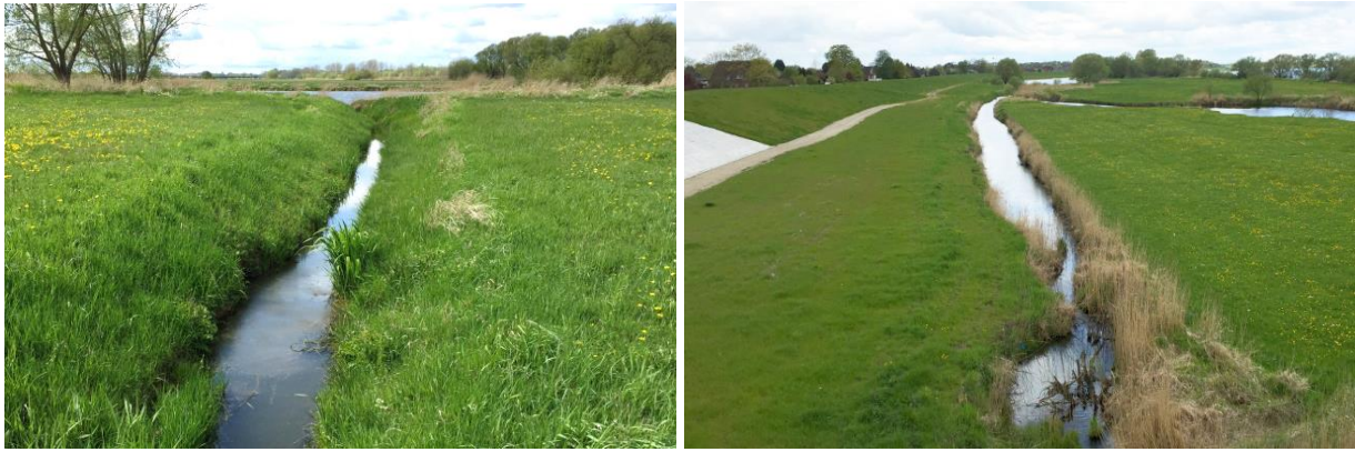
Abb. 17 Grabensystem Röner / Niedermarschachter Werder, li.: Graben im östlichen Bereich, re.: Graben westlich der B 404
