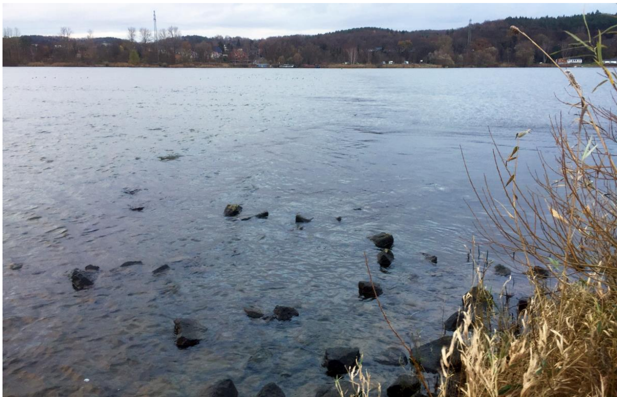
Abb. 22 Rudimente alter Buhnen mit erkennbaren Fließwechselln an der Wasseroberfläche
