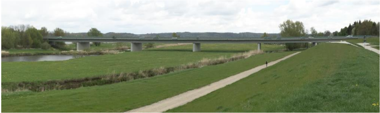
Abb. 12 Straßenbrücke B404 im Bereich des Rönner / Niedermarschachter Werder
