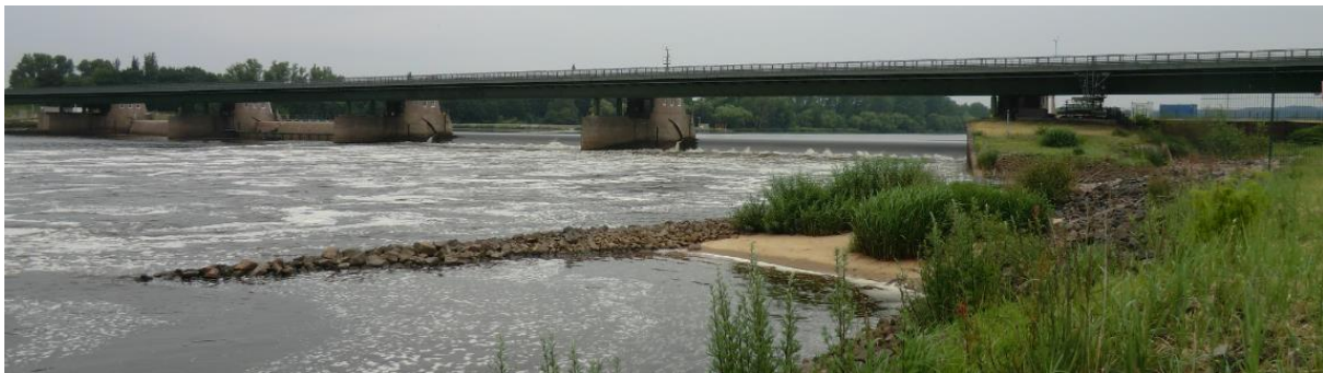
Abb. 52 Hinter der Bühne liegt der Einstieg der Fischaufstiegsanlage am Südufer der Elbe unterhalb der Staustufe Geesthacht (Foto: BBS 2015)
