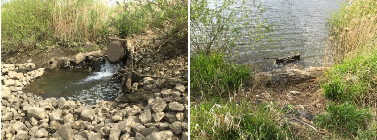
Abb. 19 Rückstauklappe, li.: bei Tnw, re.: bei Thw
