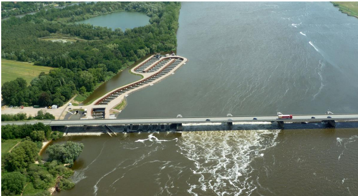
Abb. 14 Fischaufstiegsanlage am nördlichen Elbufer
