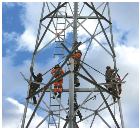
Links: Stahlgitterkonstruktion am Standort Oberstaufen © Staatliches Bauamt Kempten Rechts: Kranmontage eines 60 m hohen Schleuderbetonmasten in Gersthofen. Präzision und exakte logistische Vorbereitung der Baustellen sind entscheidende Voraussetzungen für eine erfolgreiche Montage. Der Einsatz der Transportgeräte und die Professionalität der beauftragten Spezialunternehmen sind dabei beeindruckend. © Staatliches Bauamt Augsburg
