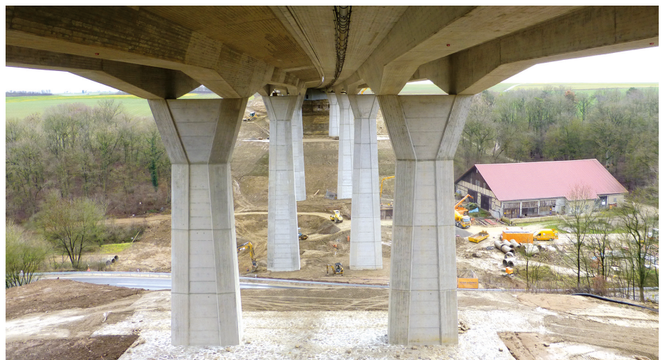
Oben/unten: Die neue Bräubachtalbrücke © Roman Wagner
