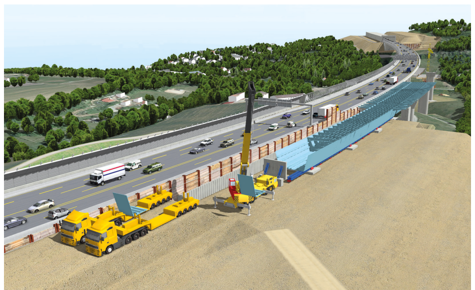
A3 bei Würzburg, Talbrücke Heidingsfeld. Oben: Ablassen des Bestandsüberbaus, fertiggestellter nördlicher Brückenüberbau. Mitte: Bau der Brückenpfeiler. Unten: Taktkeller für die südliche Bauwerkshälfte. © Autobahndirektion Nordbayern / Büro vkon, Trier
