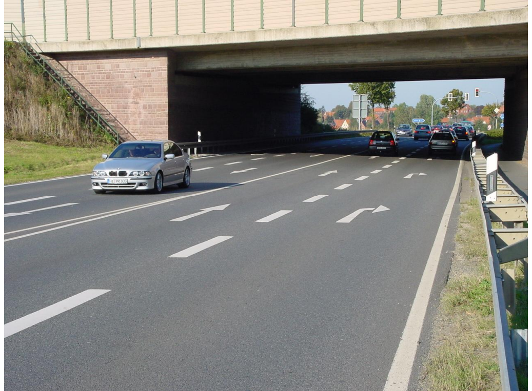
Abb. 16 Unterführung der B494 unter der A7 im Bereich der Anschlussstelle Hildesheim-Drispensstedt
