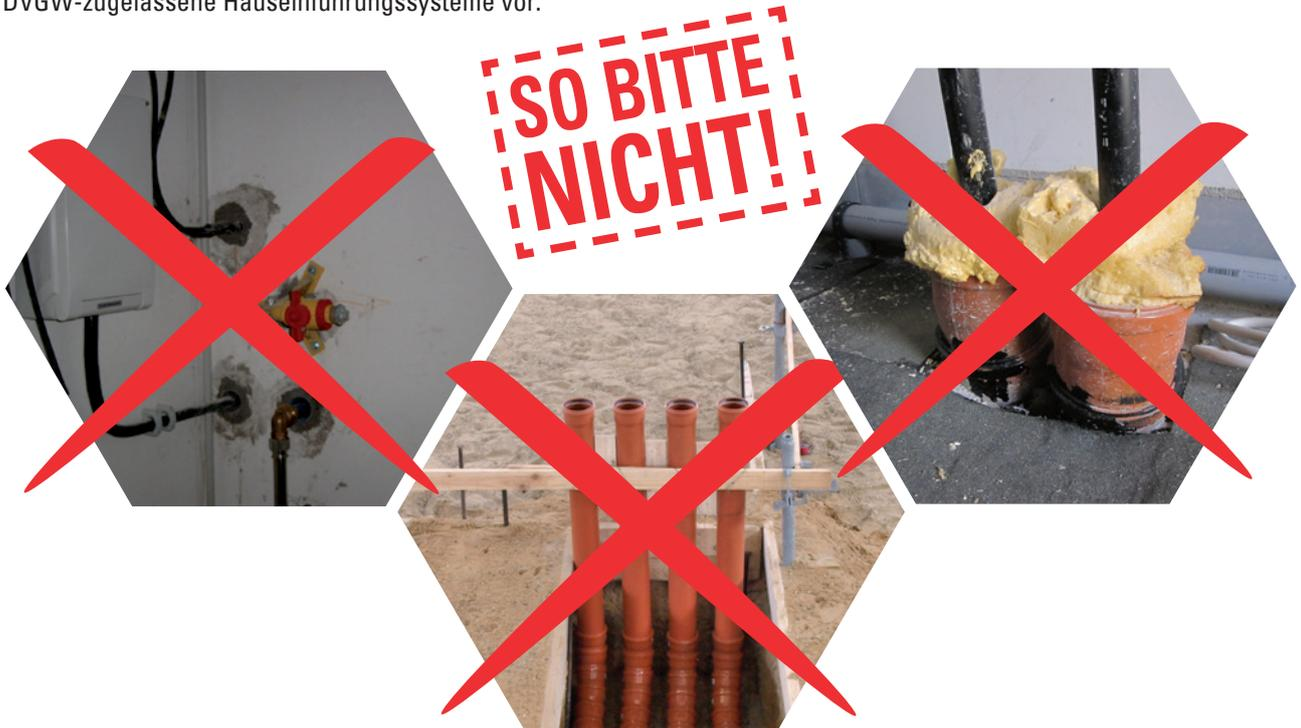
Um ein Optimum an Sicherheit zu gewährleisten, schreibt die Stadtwerke Bad Sachsa GmbH seit Oktober 2017 den dauerhaft dichten Einbau von Ein- und Mehrsparten-Hauseinführungen vor. Sie schützen dadurch ihre Kunden vor Gas- bzw. Wassereintritt aus dem Erdreich. Der Fachverband „Hauseinführung Rohre und Kabel e.V.“, FHRK, unterstützt die Aktion „regel- und fachgerechte Einführung von Versorgungsleitungen“.
