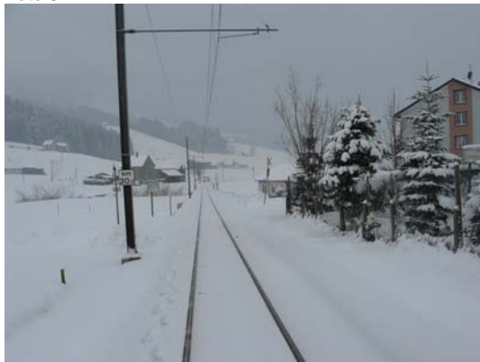
Sicht des Lokführers auf den Bahnübergang (Auto kam von rechts)
