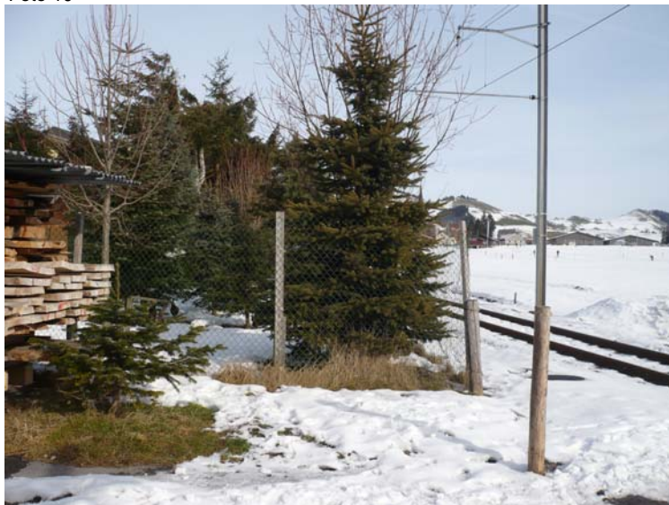
Massive Sichtbehinderung beim Bahnübergang „Wees“.
