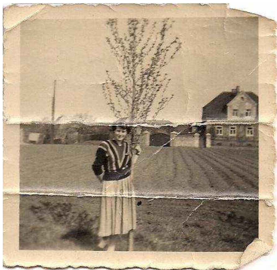
Im Herbst 1949 wurde mit der Planierung des Spielfeldes begonnen. Anschließend wurden Gras ausgesät, Pappeln und Hecken angepflanzt.
