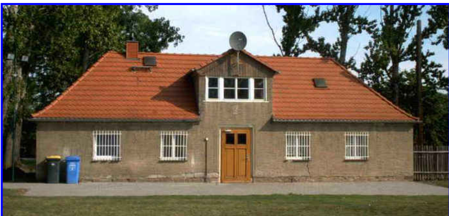
Die Neueindeckung des Sportlerheimdaches sowie die Pflasterung des Zugangsweges veränderten das Erscheinungsbild des Sportplatzgeländes schon erheblich, waren aber nur der Anfang einer stetigen Verbesserung der infrastrukturellen Rahmenbedingungen der Sportvereinigung Großgräfendorf.
