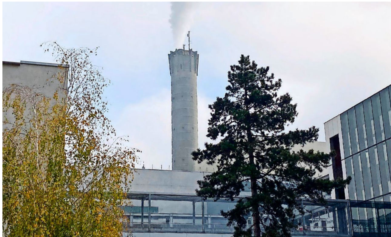
Das Stadtzürcher Fernwärmenetz hat aktuell eine Gesamtlänge von über 150 km und versorgt mit etwa 2000 Anschlüssen rund 6400 Liegenschaften. Pikant dabei: Zugefeuert wird regelmässig mit Öl.
