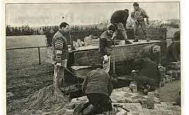
Baumarbeiten am Hülles Sportheim sind abgeschlossen Ortsrat und Bürger: Hand in Hand 450 Stunden lang hart gearbeitet
