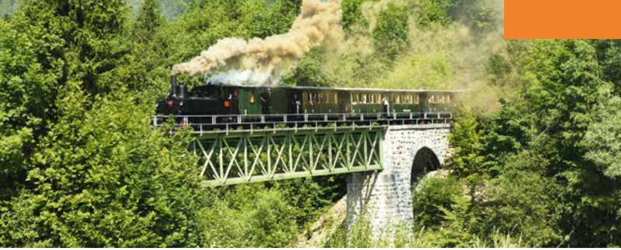
Ein Dampfzug auf der Sporeneggbrücke
