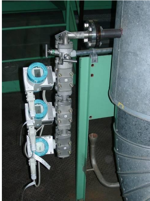
Differenzdruckmessung mit 3-fach Splitting-Range
