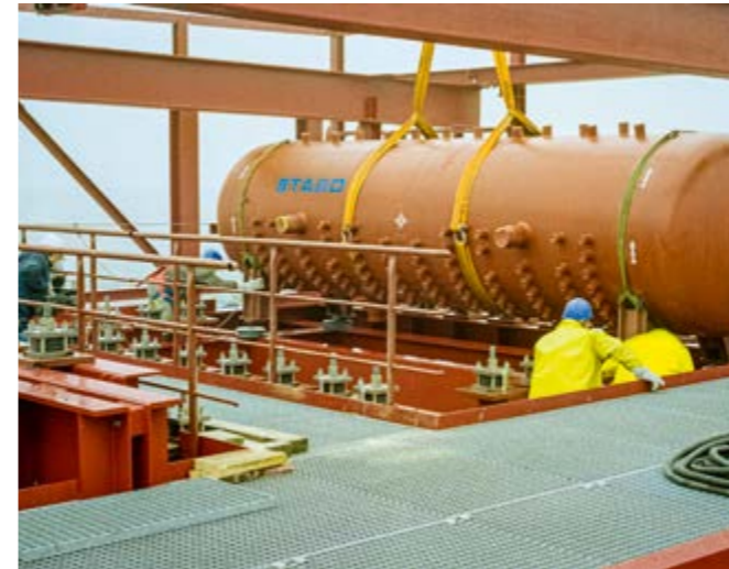
Einbau der Dampftrommel
