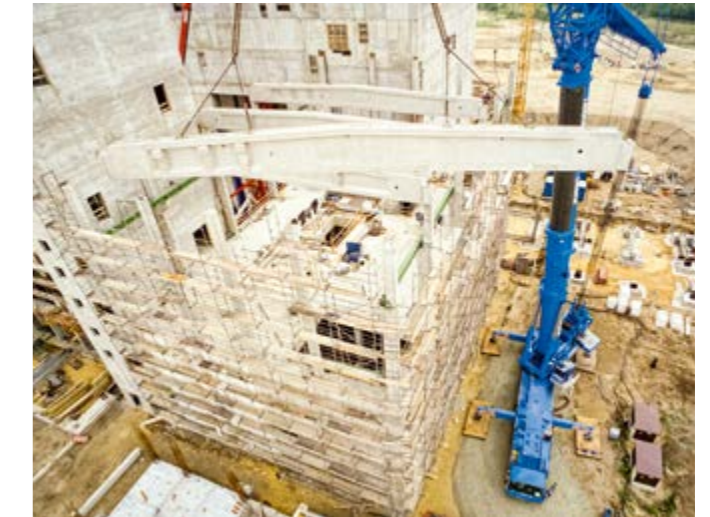
Montage des Maschinenhausdaches
