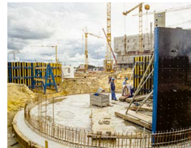
Betonieren des Multifunktionsbeckens
