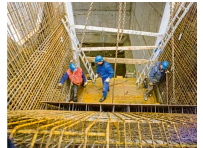
Betonbau an einer Kippstelle des Abfallbunkers
