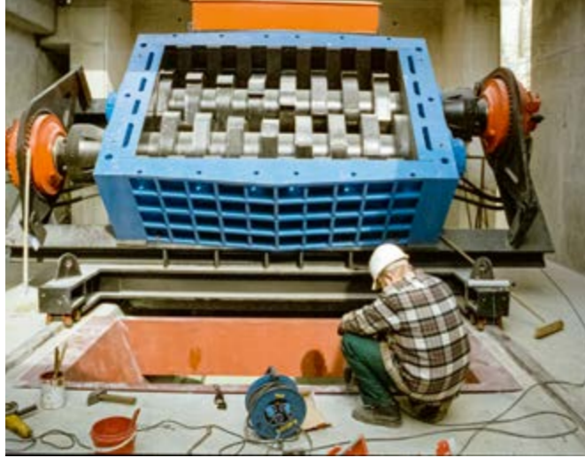
Montage der Sperrmüllschere
