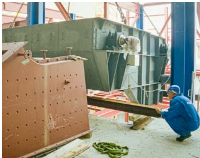
Einbau von Kanälen in das Kesselgerüst
