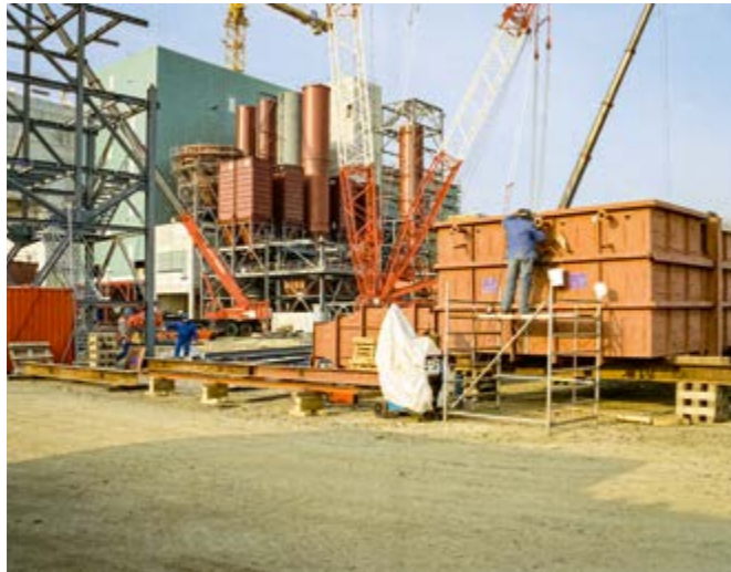
Behältermontage in der Rauchgasreinigungsanlage
