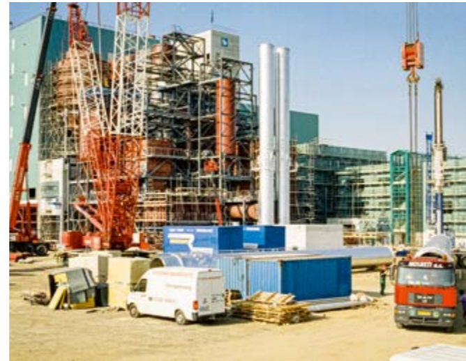
Anlieferung und Montage der Kamine
