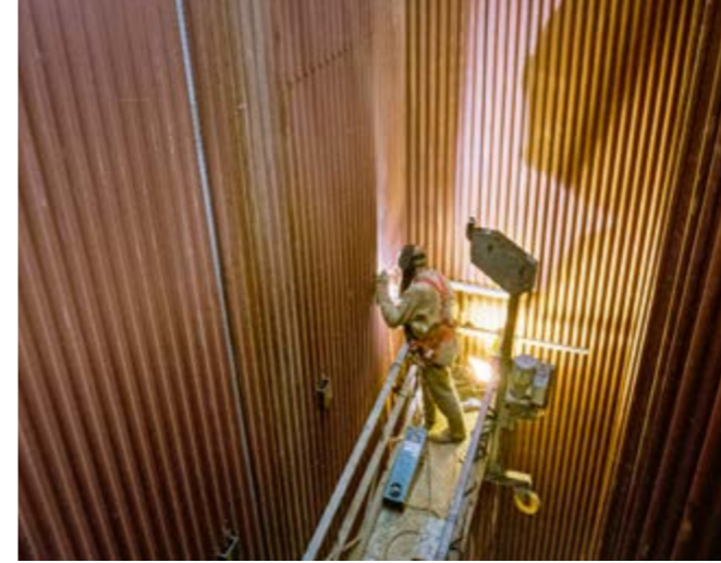
Schweißen der Membranrohrwände
