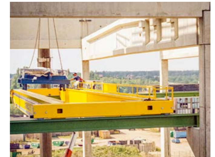
Montage des Maschinenhauskranes
