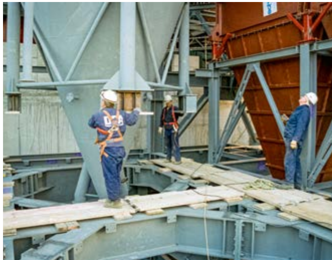
Einbau eines Silos in die Rauchgasreinigungsanlage
