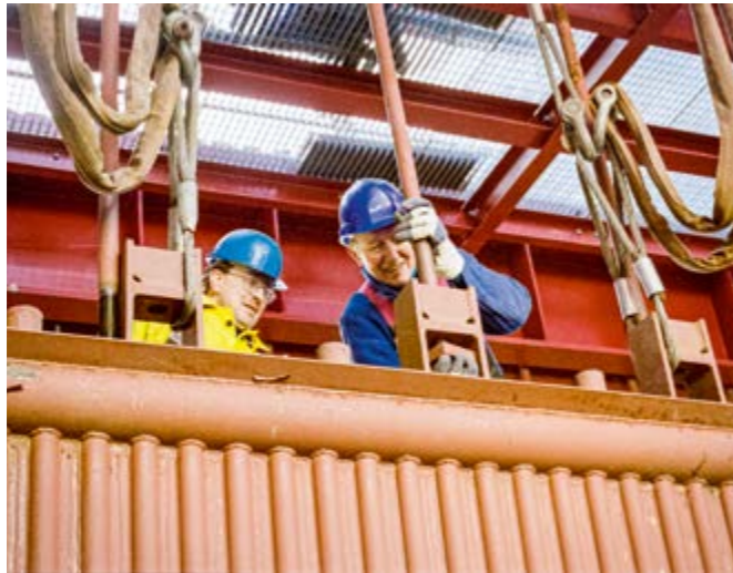
Einbau Membranrohrwand
