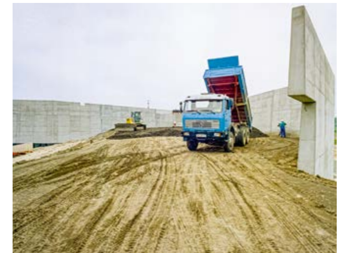
Bau der Auffahrt zur Entladeplattform
