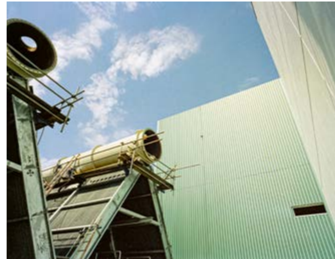
Montage des Luftkondensators
