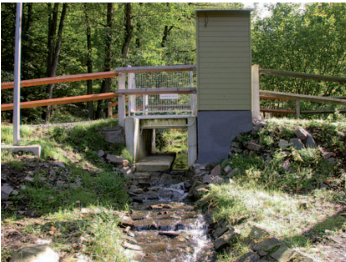
Bild 24: Zuflusspegel Schürfelde/Schürfelder Becke nach Umbau
