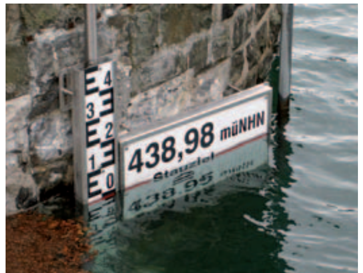
Bild 21: Neue Stauhöhenlatte an der Fürwiggetalsperre Fig. 21: New waterlevel staff gauge at the Fuerwigge reservoir
