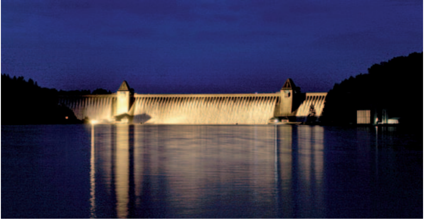
Bild 11: Hochwasserentlastungsanlage der Möhnetalsperre bei Nacht während des ersten Hochwasserereignisses im August 2007 Fig. 11: Spillway of the Moehne reservoir in operation during the first August Flood 2007
